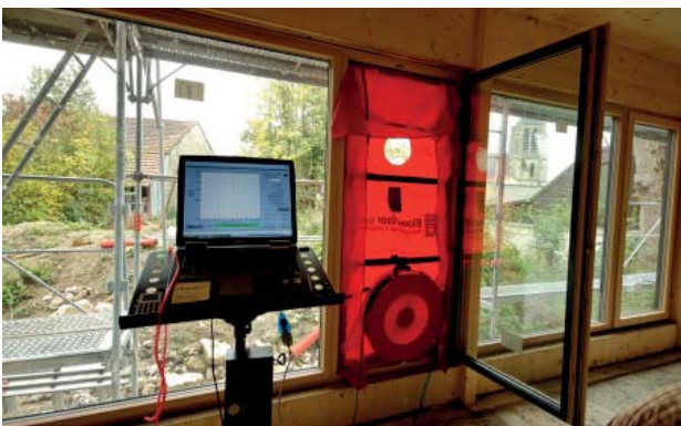
Test d'étanchéité à l'air sur la façade sud.
