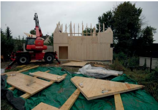
Assemblage des panneaux de bois préfabriqués.
