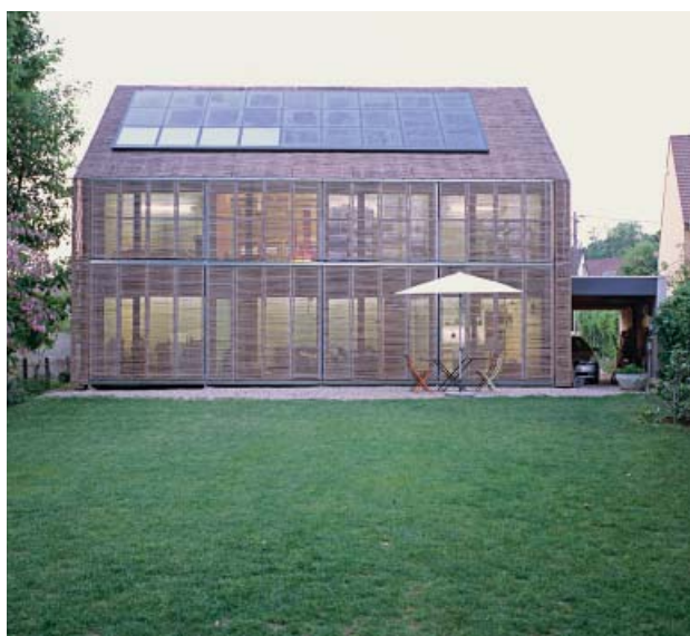
La maison vue de la façade sud. Les panneaux de bambous forment un revêtement homogène qui permet de protéger la façade sud des apports solaires. Les panneaux mobiles peuvent s'ouvrir ou se fermer complètement.
