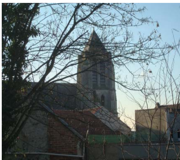
Vue depuis le jardin vers l'église. Le quartier se compose de maisons individuelles récentes témoignant de la densification progressive de la ville. Autour de l'église, le patrimoine est plus ancien.
