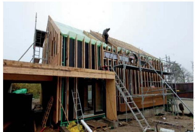
Pose de l'isolation.
