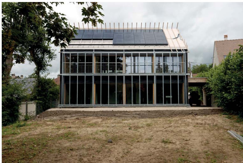
Pose des panneaux solaires en toiture sud.
