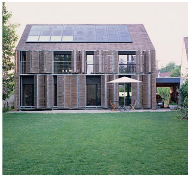
La maison vue de la façade sud. Les panneaux de bambous forment un revêtement homogène qui permet de protéger la façade sud des apports solaires. Les panneaux mobiles peuvent s'ouvrir ou se fermer complètement.
