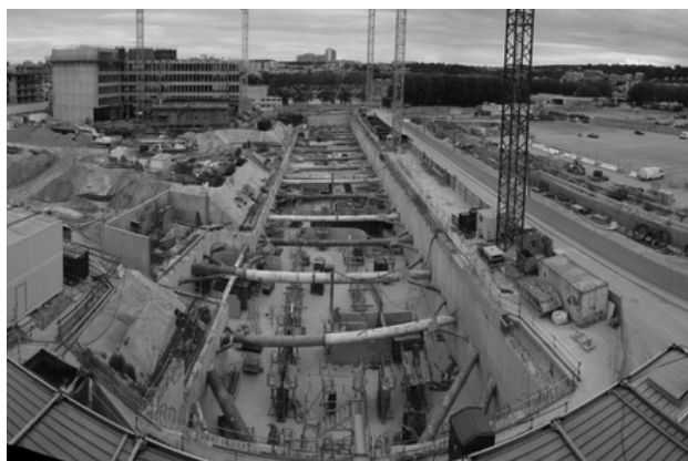
La paroi moulée des sous sols en construction
