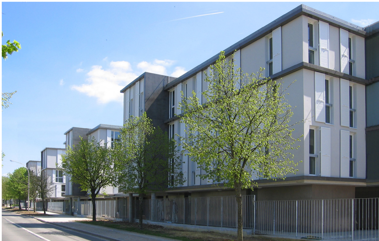
Vue extérieure sur l'avenue des Noés © Hervé Abbadie
